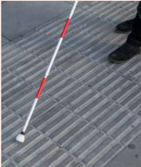
La PcS detecta las marcas del suelo que pueden servir de guía
